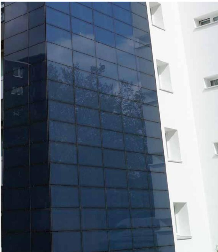
Fassade mit Photovoltaikmodulen.
