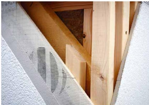
Gefachdämmplatte der Inthermo Vorhangfassade.
